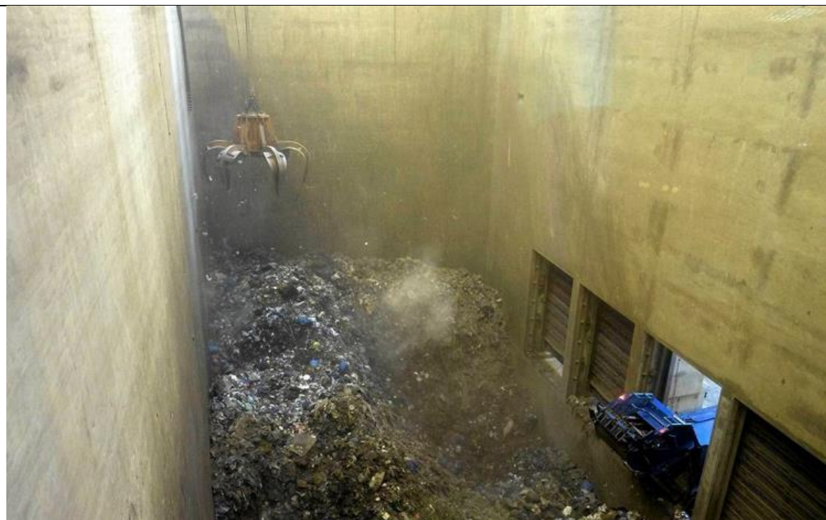
Przykład bram ryglowanych w ITPOK Poznań (po lewej stronie)
